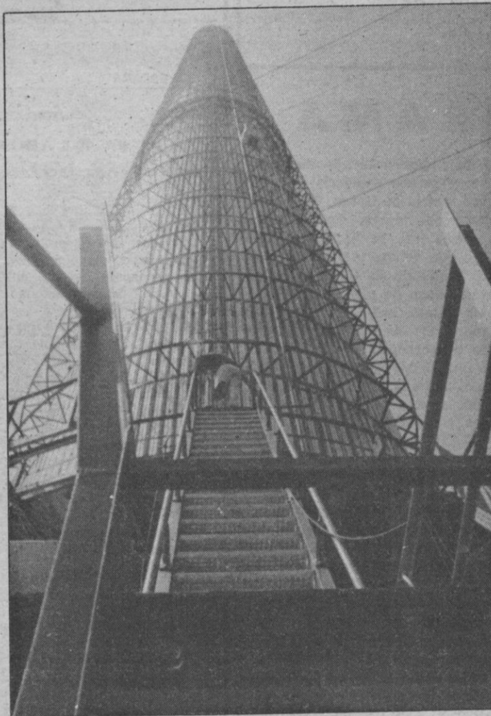
Manzanares (Ciudad Real).—Exterior de la central eólico-solar que ha sido inaugurada en esta ciudad manchega por el director general de la energía, José del Pozo Portillo, y el secretario de Estado alemán para Temas de Energía. Esta es la primera central eólico-solar del mundo basada, no en el aprovechamiento del viento natural, sino en su creación, mediante la inducción de calor solar.—(Foto EFE)
