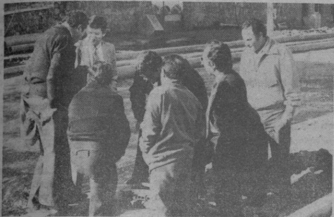
Visitando las obras del Paseo Nuevo
