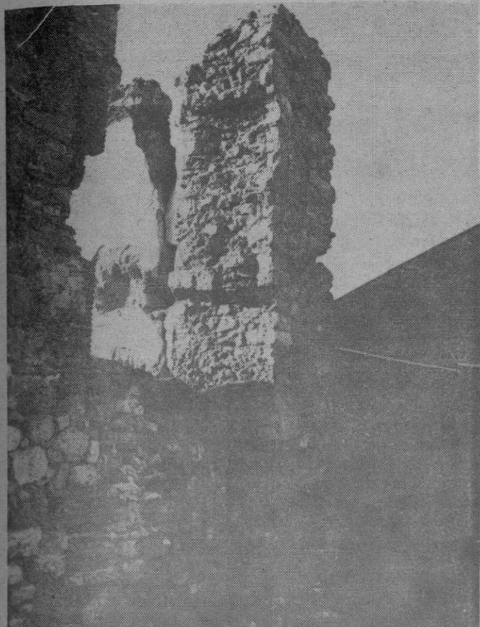
Al final de la calle de Malconsejo, junto a las viviendas de Pio XII de la calle del Taray, en la parte posterior de los locales de nuestro periódico, existe un fragmento de muro que está amenazando peligrosamente con derrumbarse. Como en la fotografía puede observarse, la base de ese trozo de muro está seriamente aligerada, por lo que la caída podría producirse en cualquier momento.
