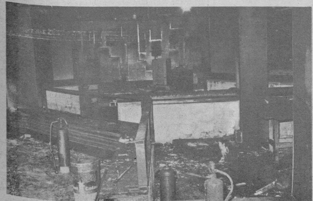
Varios aspectos de los daños ocasionados en la discoteca. (Fotos Aurelio M.)
