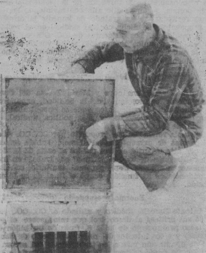
Un vecino de Tabanera muestra uno de los registros de la conducción de agua construida al mismo tiempo que las pavimentaciones.
