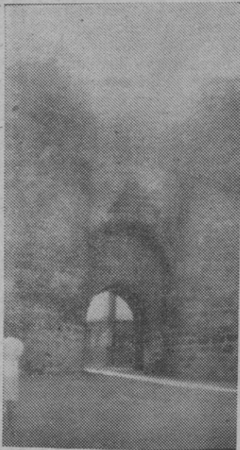
Otra de las tres puertas del recinto murado de la villa, superviviente de las seis con que llegó a contar el recinto medieval.
