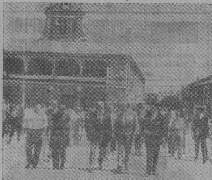
En Mozoncillo, las autoridades se dirigen a una de las obras a inaugurar.—(Foto Antonio)
