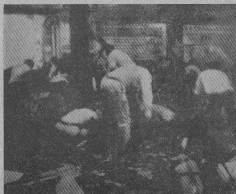
Un edificio de la calle de Fuencarral, en Madrid, que había sido declarado en ruinas y se encontraba deshabitado desde hace dos años, se derrumbó ayer. Ocho personas resultaron muertas y varias otras heridas. En la fotografía, momento del rescate de víctimas, la mayoría de las cuales se encontraban en la terraza de un bar, junto a la finca derrumbada. (Información en pág. 8.)
