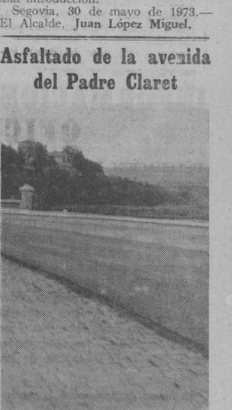
He aquí un detalle de las obras de asfaltado que se están realizando—y de las que ya informamos—en la avenida del P. Claret. La capa de macadam alcanza varios centímetros sobre el antiguo adoquinado.—(Foto A. M.).
