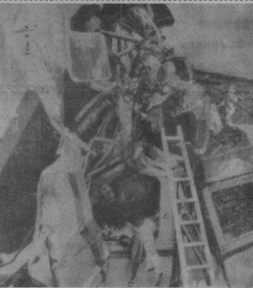
Una vista del estado en que quedaron las dos primeras unidades del ferrobús, convertidas en montones de chatarra aprisionando entre sus hierros retorcidos a las víctimas del accidente.
