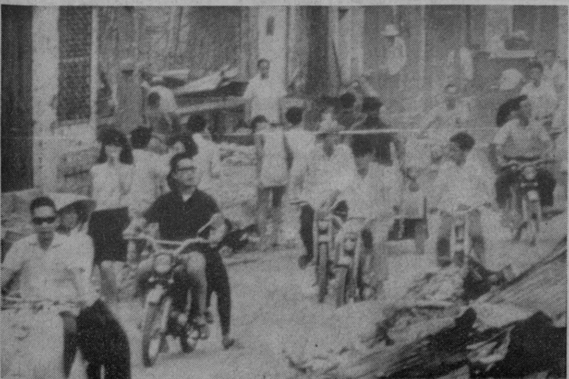
Saigón.—Personas civiles cruzan las calles de Saigón en sus motocicletas; ya no puede decirse que a los lados están las casas... ya solamente quedan ruinas y ruinas en toda la capital survietnamita. Sobre todo en el barrio chino de Cholón, al noroeste de la ciudad.—(Telefoto AP-Europa Press)
