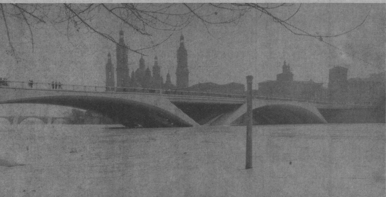
Zaragoza.—El río Ebro ha sufrido una gran crecida a consecuencia de las continuas lluvias de los últimos días y el gran caudal que le llega del Jalón, que está ocasionando en Catalunya y su comarca graves inundaciones, que hacen peligrar muchas cosechas. En la fotografía, una vista del Ebro a su paso por Zaragoza. Al fondo, el Pilar.—(Foto Europa Press.)
