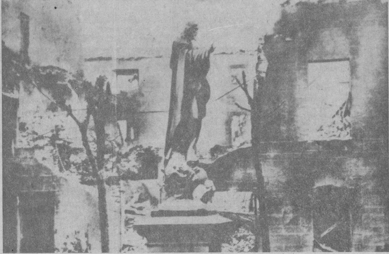
Imagen del Sagrado Corazón de Jesús que permaneció erguida en su pedestal, después del incendio del Colegio de Chamartín de la Rosa (Madrid), de los padres Jesuitas, que quedó reducido a un montón de ruinas como puede apreciarse. —(Foto Cifra)
