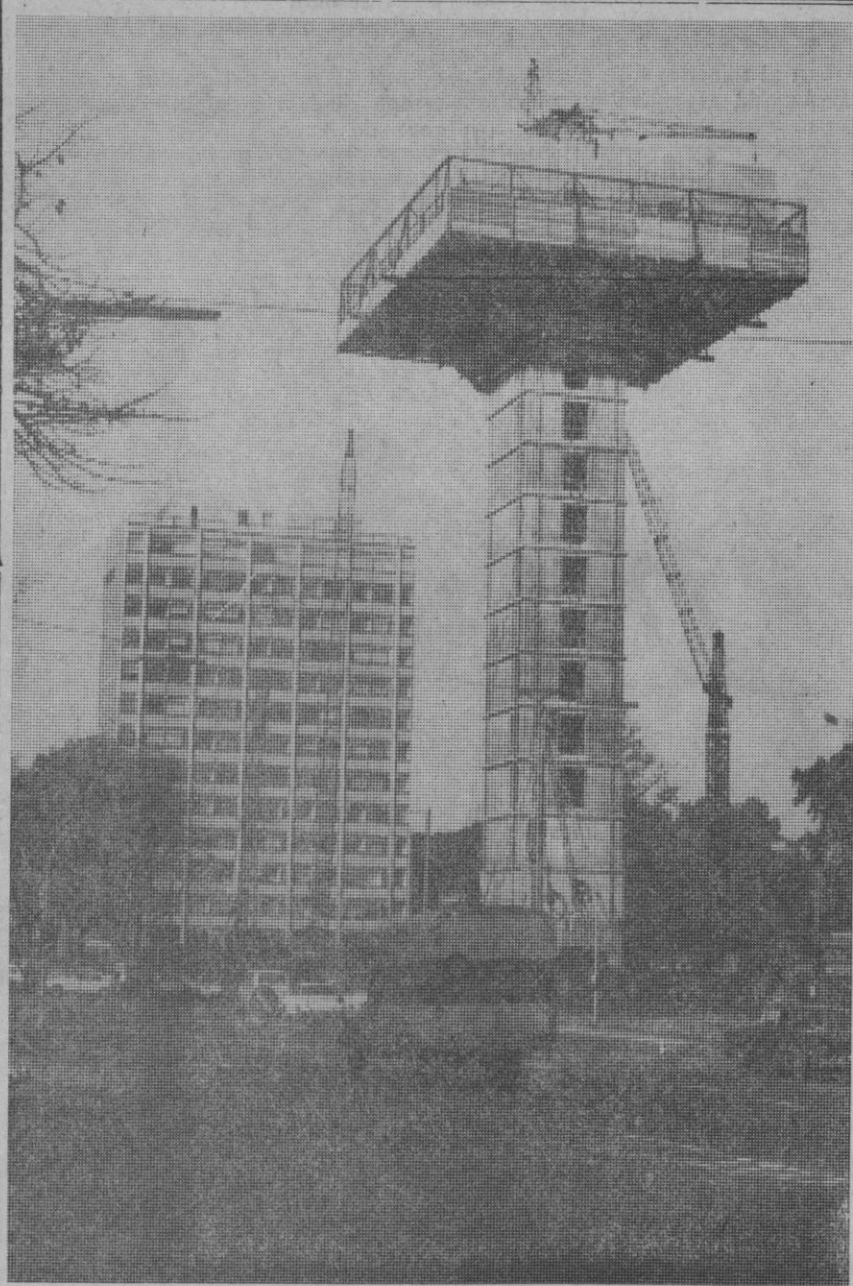
Arquitectos alemanes se entusiasman últimamente por un método de construcción descomunal, haciendo crecer grandes casas de oficinas de arriba para abajo. El primer ensayo de esta índole lo constituye la Casa de Finlandia, en Hamburgo, de trece pisos, la que se intenta inaugurar a mediados o a fines del año próximo. Una vez montadas en la torre, la que contendrá los ascensores y las tuberías y cables de abastecimiento, las vigas de acero, la plataforma de construcción es descendida a trozos, colgándose cada semana un piso en el otro. El edificio está destinado para dar alojamiento a firmas finlandesas
