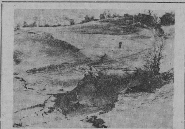
Otra impresionante vista de las afueras de Reocín (Santander), en la que el terreno aparece hundido o cubierto de grietas, a causa del derrumbamiento de varias galerías de las minas de cinc. (Foto Fiel.)
