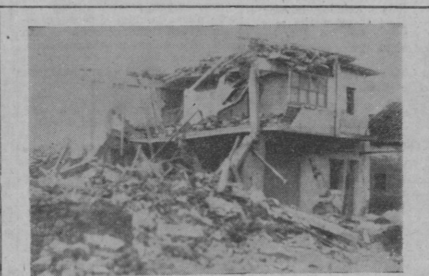
Como esta casa han quedado muchas en el pueblo de Reocin, Santander, tras el movimiento de tierras producido por el hundimiento de la mina de cinc allí existente y que es la más importante de España
