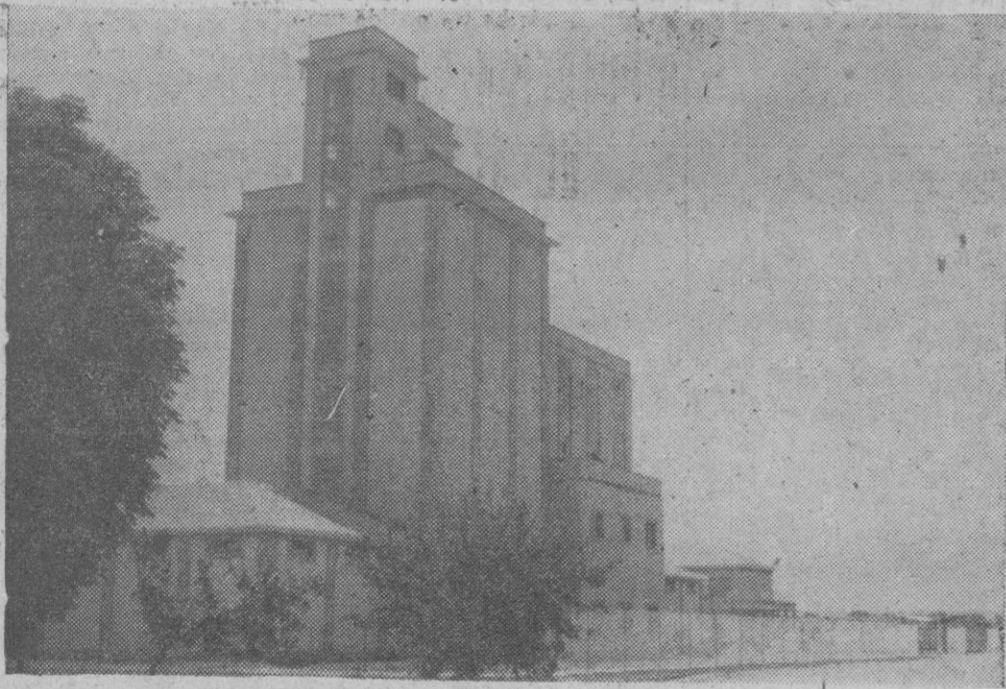
He aquí una perspectiva del magnífico silo situado en la localidad burgalesa de Aranda de Duero, en el que se recogen los productos que más tarde habrán de ser transformados, mediante el adecuado proceso, en PIENSOS COMPUESTOS
