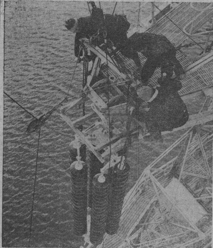
A más de ciento veinte metros de altura sobre el río Forth, en Escocia, se coloca en posición un aislador de supresión, en una torre de la orilla norte del río. La torre es parte de un tendido que atraviesa el río para conectar una nueva central generadora eléctrica, en el lado norte, con la red del lado sur
