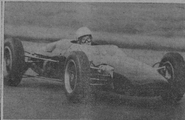
El nuevo coche de carreras "Lola" Fórmula I, que está propulsado por un motor zaguero V8 Coventri Climax, con caja de cinco velocidades. Tanto a las ruedas delanteras como a las posteriores se aplican frenos de disco, y la esbelta carrocería está hecha de fibra de cristal
