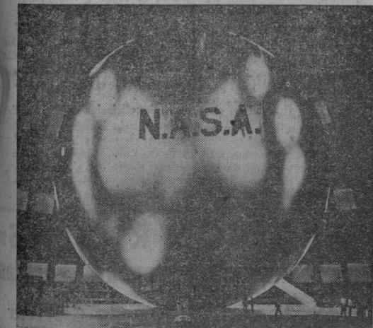
En la ciudad de Weeksville, en Carolina del Norte, en un hangar de dirigibles está siendo sometido a pruebas de resistencia a la tracción un balón satélite inflexible de material rigidizado de 41 metros de diámetro. En el momento del lanzamiento irá plegado dentro del recipiente que se ve en primer término. Este balón satélite de comunicaciones es veinte veces más rígido que su prototipo el "Eco I" que fue lanzado al espacio el 12 de agosto de 1960
