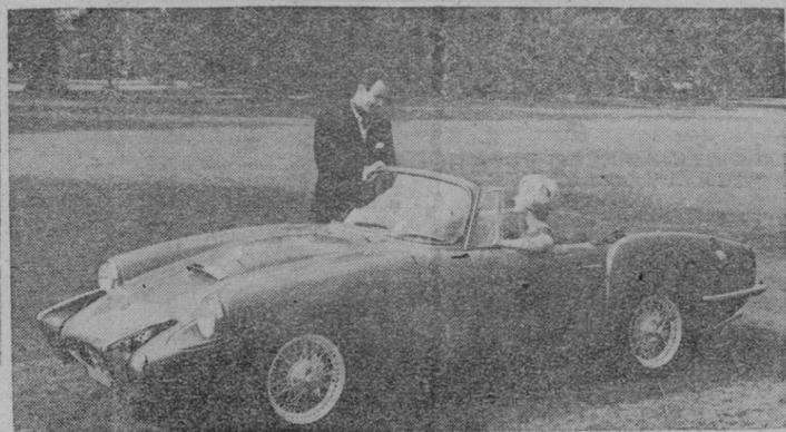
Este atractivo y nuevo modelo de coche de deportes, el Reliant "Sabre", tiene cuatro cilindros y 1.7 litros de cubicación, desarrolla una velocidad máxima de ciento sesenta kilómetros por hora, y consume de ocho a once litros por cien kilómetros. La carrocería aerodinámica es de lana de vidrio reforzada, sobre un robusto chasis de acero, así es que combina rigidez y asistencia. Tiene frenos delanteros de disco y cinturones de seguridad.
