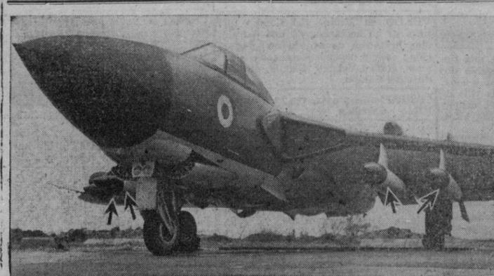
es automática. Bajo las alas (indicado con flechas) hay cuatro lanzadores de fibra de cristal, de 24 tubos cada uno. El "Sea Vixen", que es el avión de mayor potencia de ataque con cohetes, aire-aire y aire-tierra, puede disparar casi instantáneamente sus 124 cohetes, y el hecho de que pueda llevar toda esta carga se debe al empleo de lanzadores de fibra de cristal, de poco peso, que fueran demostrados recientemente ante jefes militares de la Organización del Tratado del Atlántico Norte
