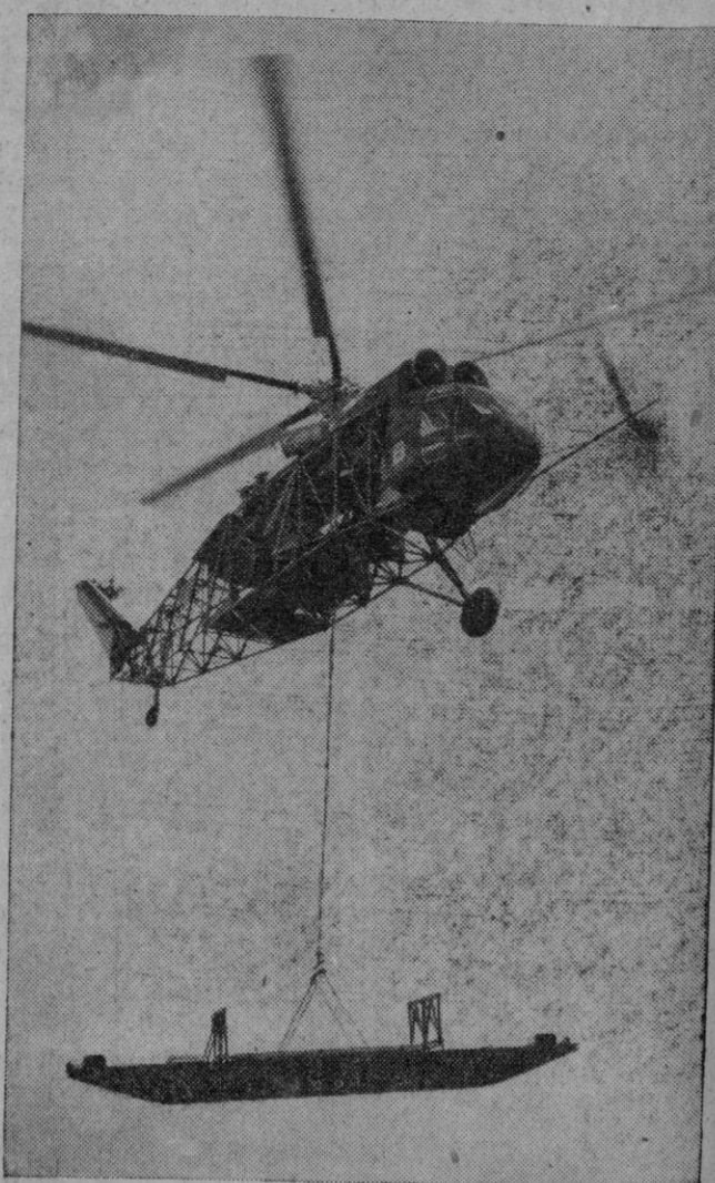
Este helicóptero, que hace una demostración de su capacidad de levantamiento de pesos, es un Westland «Westminster» para trabajos pesados, dedicado actualmente a vuelos de pruebas de motores y del planeador. En esta fotografía levanta una sección de un puente flotante de asfalto, del tipo empleado por el Ejército británico. La sección, que pesa tres mil treinta kilos y mide diez metros y siete centímetros de longitud por seis de ancho, fue levantada y transportada con gran facilidad. La operación se realizó sujetando la sección con una estinga de cable, asegurada a un gancho de desenganche rápido que forma parte del planeador
