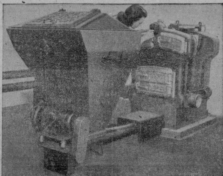
En Guildford, Surrey (Inglaterra), se celebró una exposición para demostrar los últimos adelantos técnicos de los equipos de calefacción doméstica. El sistema empleado en este equipo permite que el horno vaya alimentándose de combustible, a medida que va bajando la temperatura deseada, de acuerdo con el reostato
