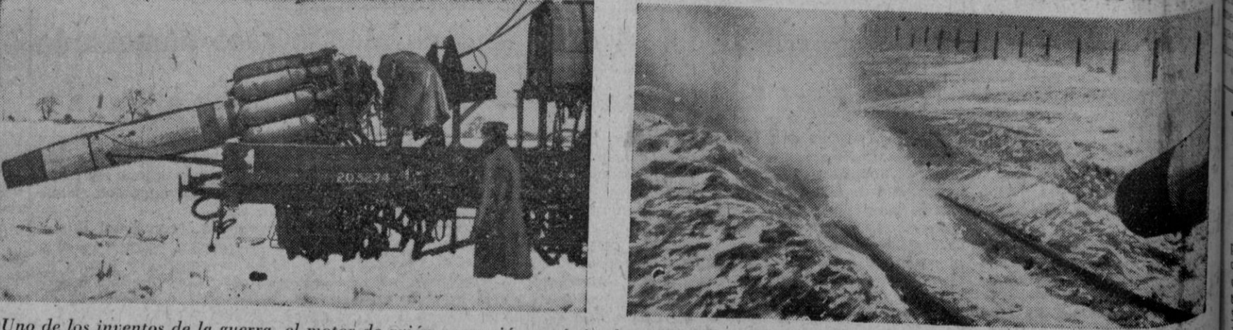
Uno de los inventos de la guerra, el motor de avión a reacción, está siendo aplicado contra la nieve en Inglaterra, cuyo país sufre por dicha causa grandes dificultades en su sistema de transporte. En la foto de la izquierda vemos la instalación de uno de dichos motores en un vagón de ferrocarril, y en la segunda, cómo la nieve de la vía queda disuelta por la acción de un «chorro» de aire caliente
