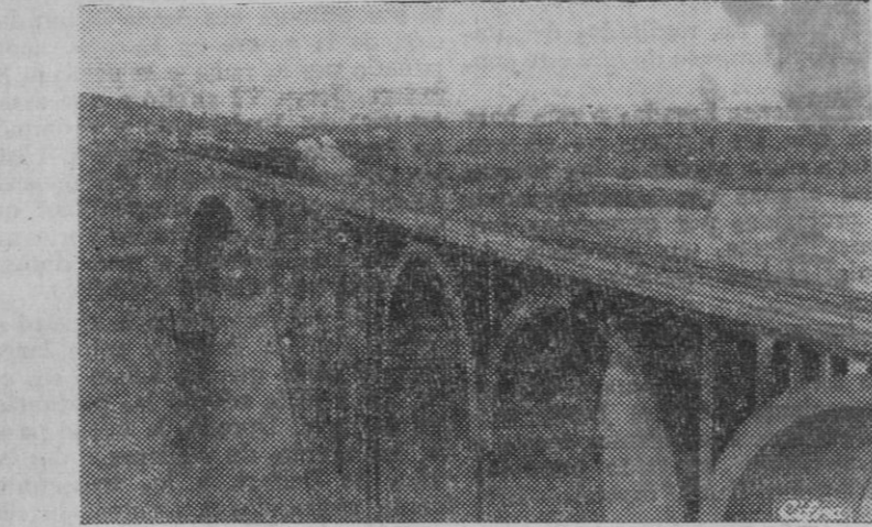
Sobre el Viaducto del Esla pasa el ferrocarril. Son demostración de la capacidad potencial de la técnica española. Sobre el Viaducto construido por el nuevo Estado, cruza la línea férrea cuya circulación tan esencial es para la economía española. Indudablemente la perspectiva tiene la belleza de una técnica al servicio de la utilidad
