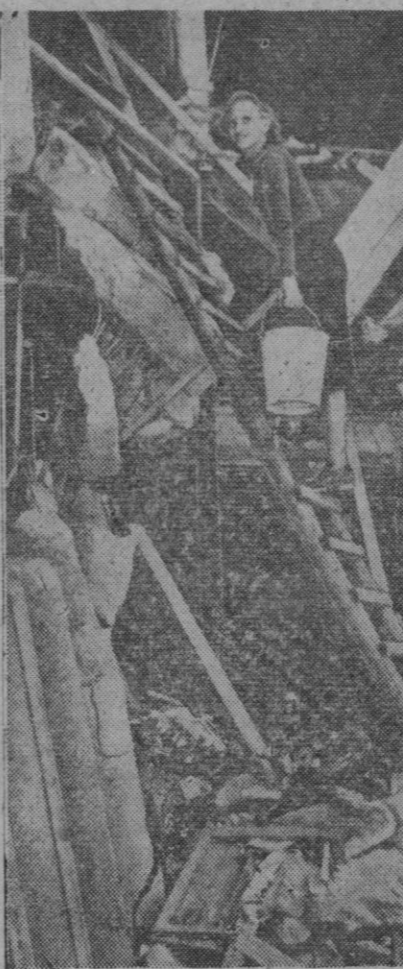
Los destrozos de las bombas ocasionan duras pruebas, pero hay que soportarlas con sangre fría. Esta señora ha visto destruida su casa de cuatro pisos, en una de las ciudades del Oeste de Alemania. Sólo le ha quedado intacta una habitación, y en ésta, se han acomodado ella y su marido, provisionalmente. Como el agua es indispensable y las tuberías no funcionan, debe ser subida en cubos desde el patio, utilizando una escalera de mano.
