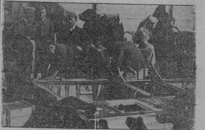
Obreros franceses en una fábrica de aviones alemanes, reparando el fuselaje de un aparato que ha sufrido averías en un vuelo.
