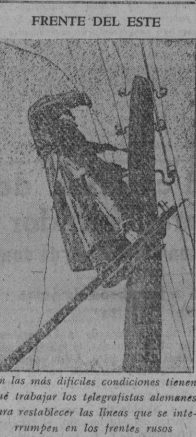
En las más difíciles condiciones tienen que trabajar los telegrafistas alemanes para restablecer las líneas que se interrumpen en los frentes rusos
