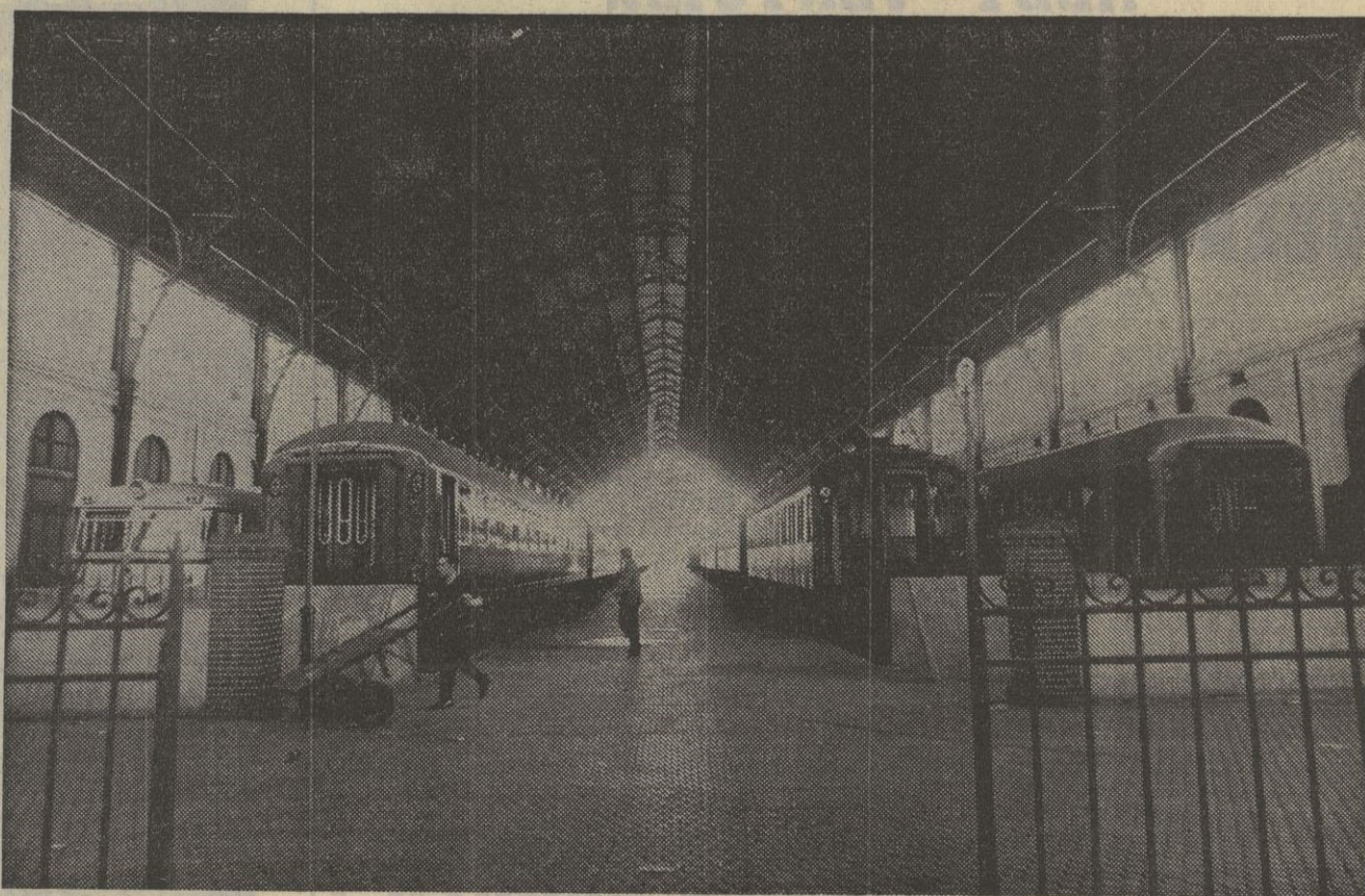
La estación de las Delicias ya no existe. Ha pasado a ser parte de la historia del distrito
