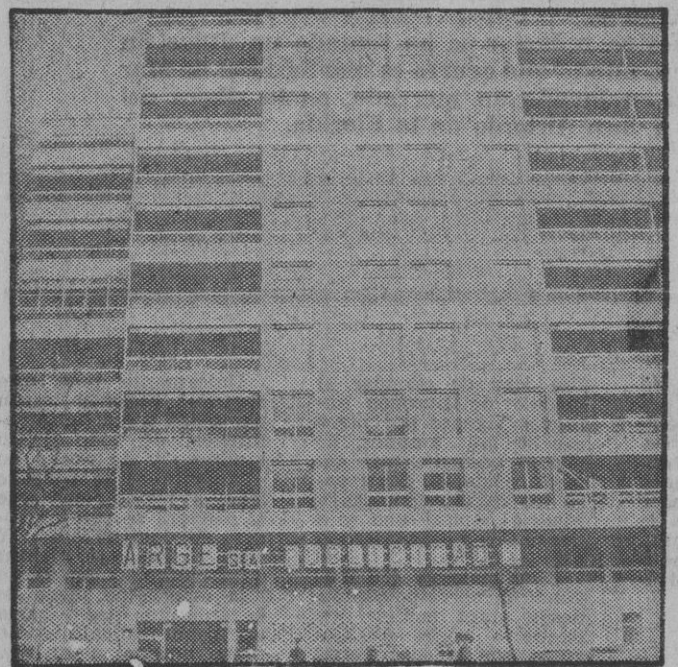
Vista del edificio
