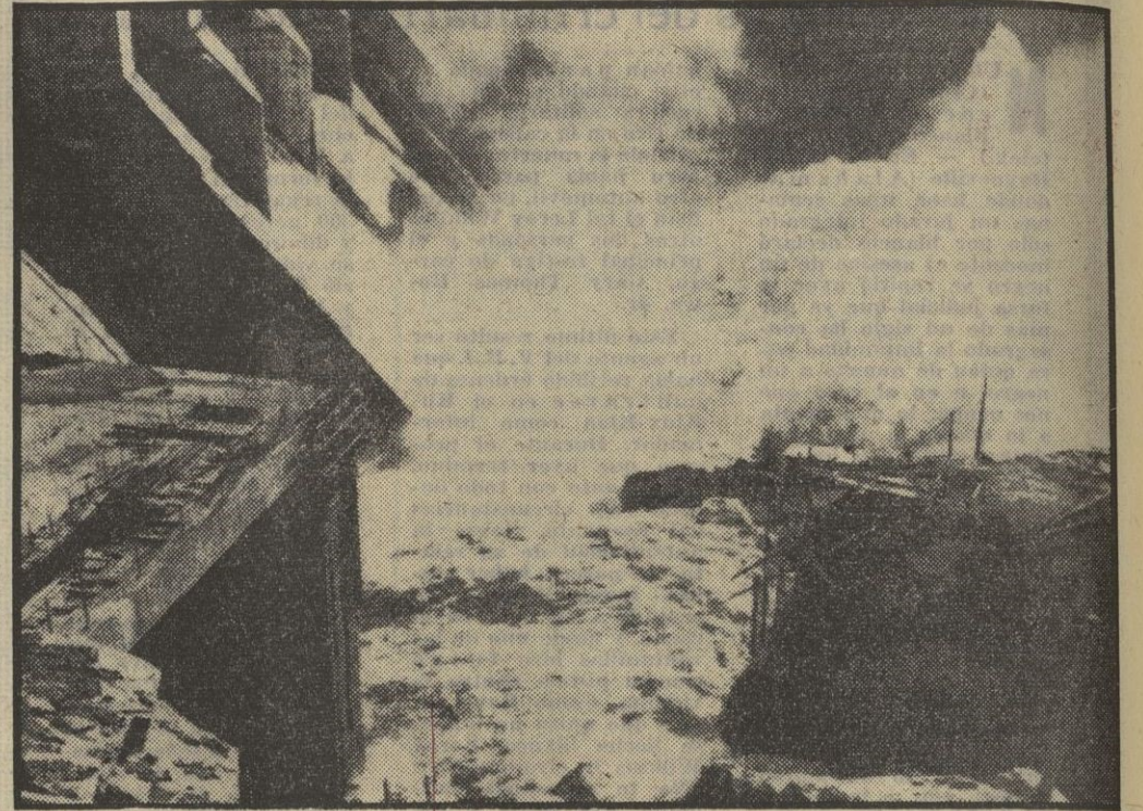
La presa de Torrejón Rubio, después del accidente. (Fotofax PUEBLO.)
