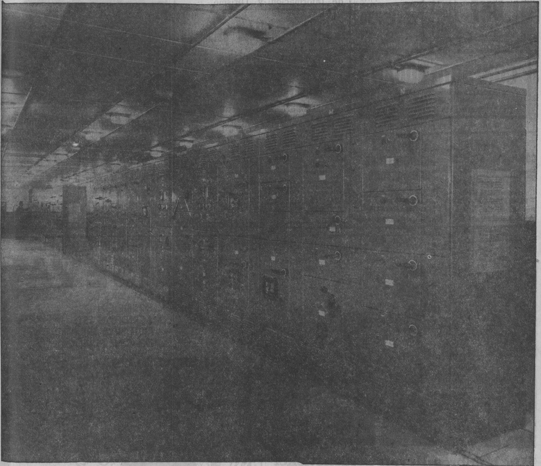
Centro de control de motores G.E.C. de 415 V en la refinería de Regent, cerca de Pembroke, Inglaterra. Desde este centro se controlan 300 motores de inducción.
