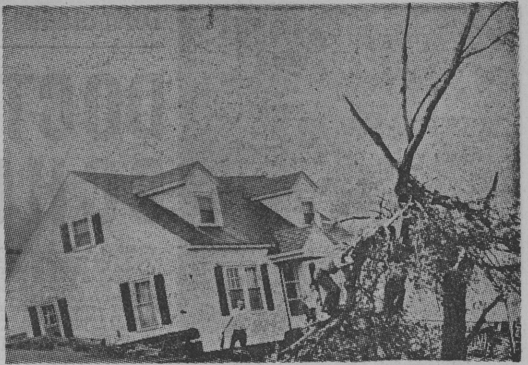
EL AIRE ARRANCO LA CASA Esta casa fué arrancada de su base por el fortísimo tornado que se desencadenó en la comarca de St. Marmó (Pensilvania). La violenta tormenta ocasionó considerables daños materiales, pero no hubo que lamentar desgracias personales. (Foto Cifra.)
