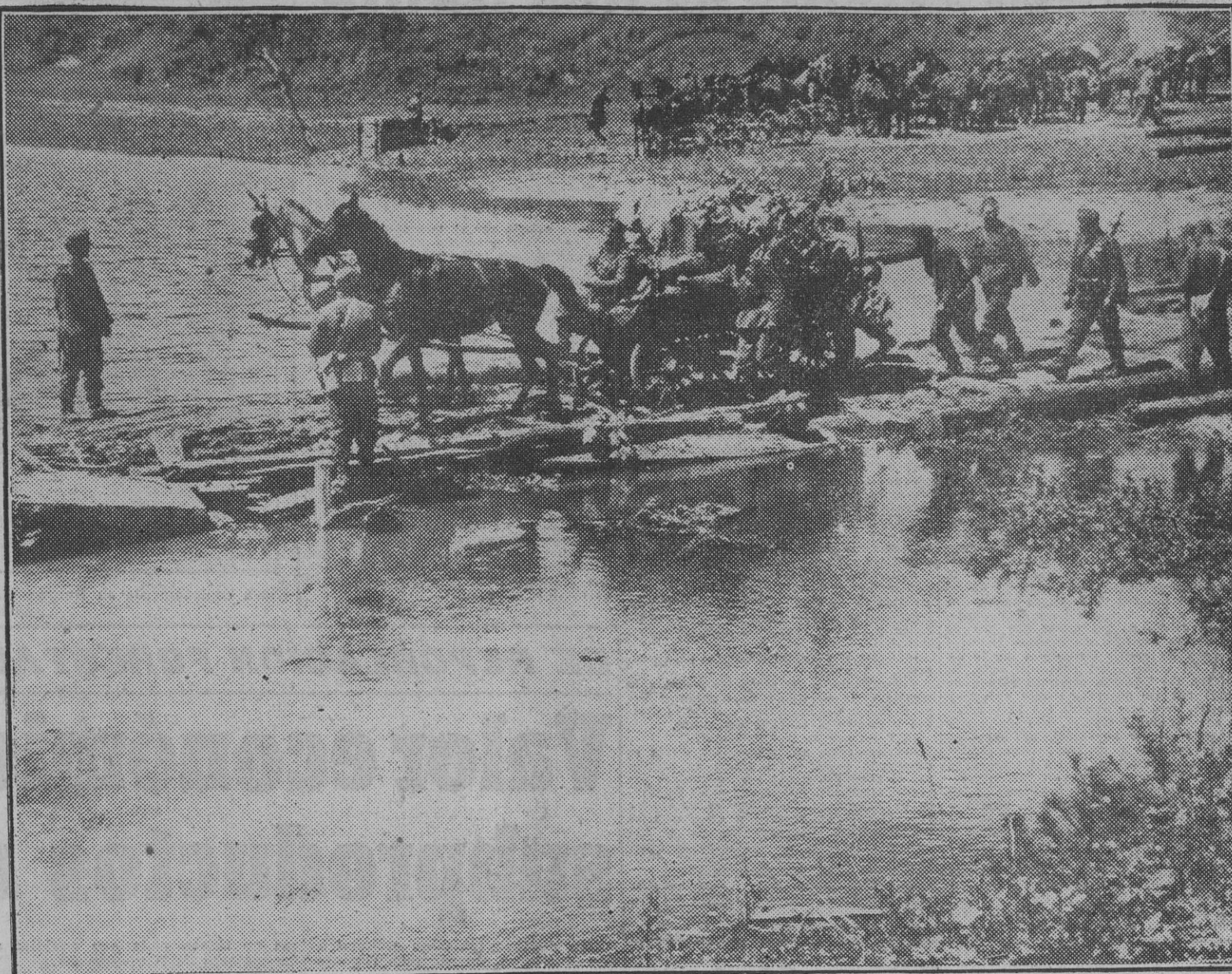
Los pontoneros alemanes han dispuesto con cuatro tablas un paso provisional para franquear un afluente del Don. Hombres y carrajes pasan rápidamente sobre el estrecho camino. (Foto Orbis.)
