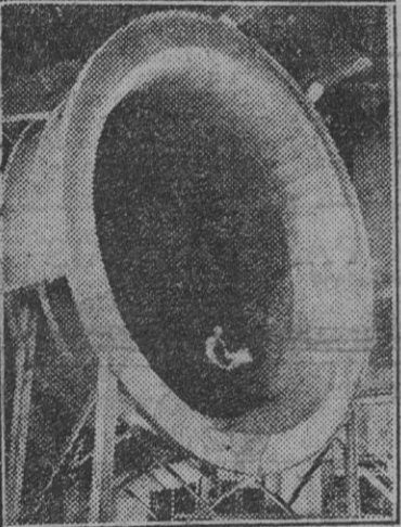
En Dayton (Ohio) está instalado un gran laboratorio aeronáutico; el Laboratorio Wright. Este enorme tubo aerodinámico (observarse el reducido tamaño del hombre) sirve para probar el material aéreo. Fúndese en las mismas presiones que sufrirían en vuelo mediante un viento artificial que llega a alcanzar la velocidad de 400 millas por hora. (Foto Fando).
