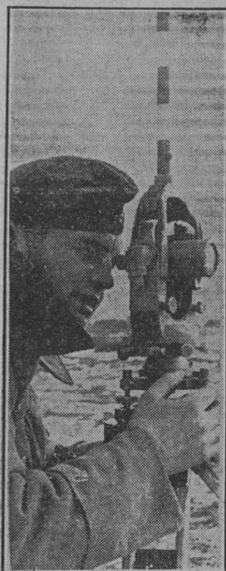
Este oficial de artillería sigue atentamente con auxilio del teodolito la precisión de tiro de una batería alemana y comunica los ángulos de rectificación precisos para la mejor eficacia del disparo. (Foto W.)
