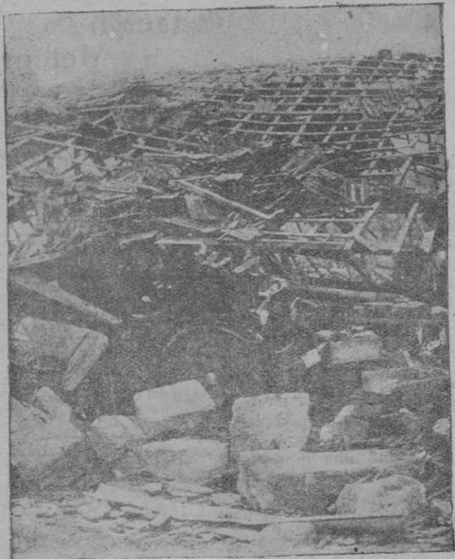
Restos de un garage, hundido a consecuencia del ciclón que azotó la ciudad de Pontevedra
