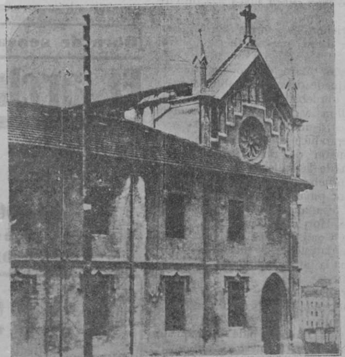
Fachada del convento de Carmelitas descalzas de Beñosa, donde, a consecuencia del temporal, se desprendió el campanario y destruyó la bóveda, originando la muerte de una monja
