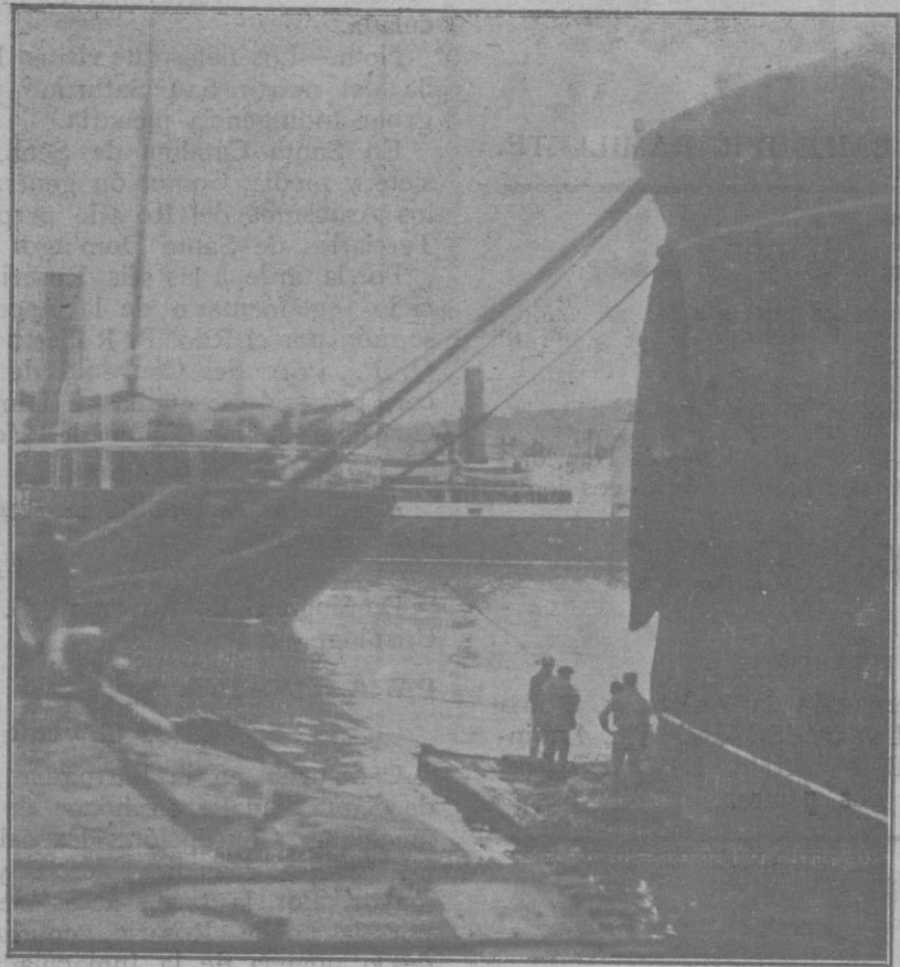
Como quedaron los bloques del malecón del Muelle a causa del accidente. Los operarios reparando la proa del vapor
