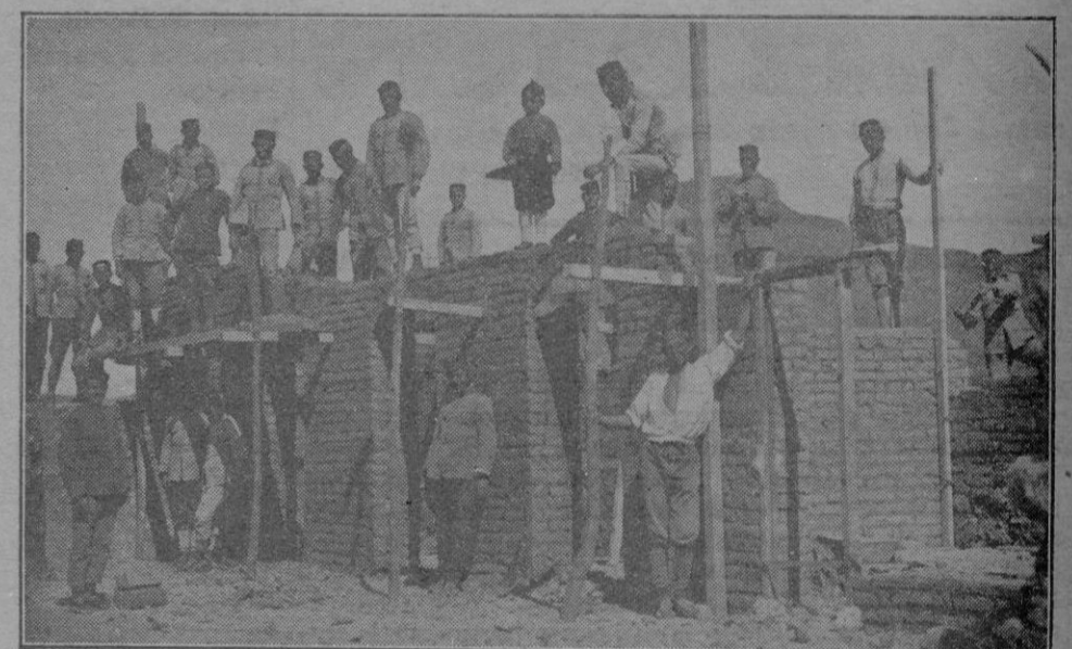
Barracón en construcción por parte de los soldados
