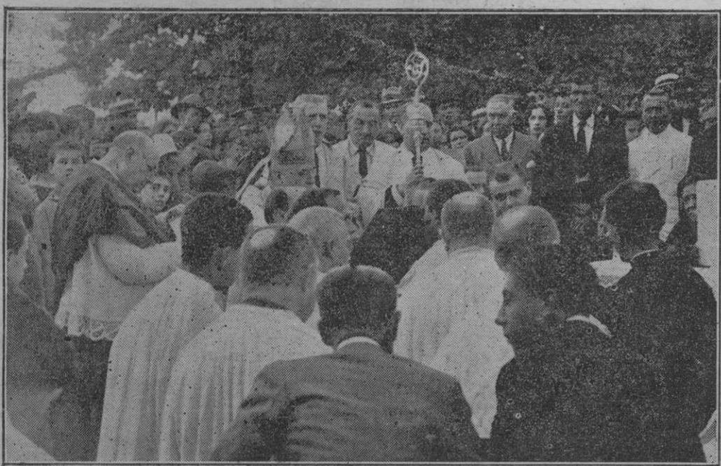
El Ilmo. Obispo bendiciendo la primera piedra de la iglesia que se levantará en «San Flexas» (Molinar de Levante)
