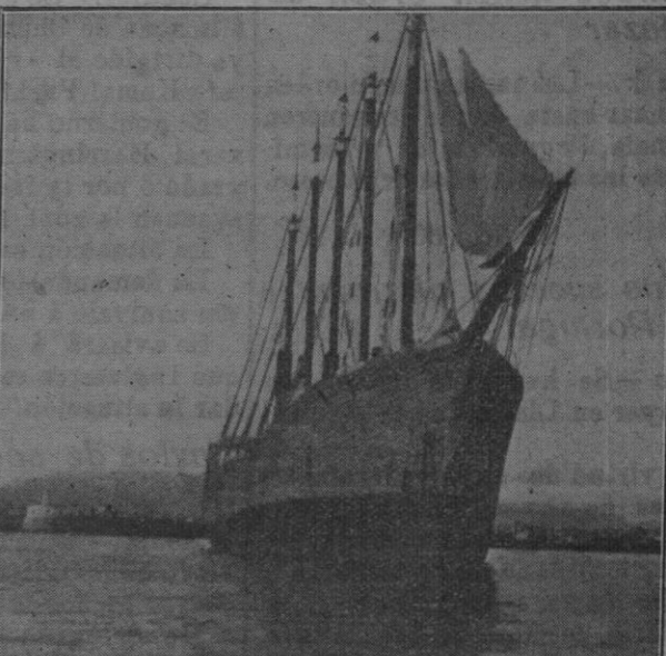
El pailebot «Comandant Rossi» fondeado en nuestra bahía, adquirido por el naviero mahonés señor Parpal, para desguazarlo. Desplaza 5.000 toneladas y cuenta solo unos tres años, desde que fué construido. Está dotado de dos máquinas de triple expansión, que le imprimen un andar de nueve millas por hora. Aunque fué construido en uno de los astilleros de New-York, viene abanderado con el pabellón francés, en cuya nación fué adquirido por uno de aquellos navieros, así que hubo rendido su primer y único viaje a Marsella.
