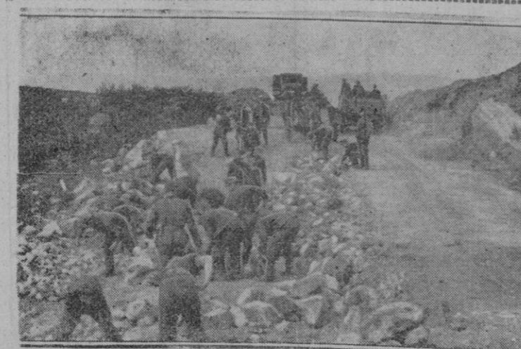
EL SERVICIO DE TRABAJO ALEMÁN EN EL EXTREMO NORTE DEL ESTE.—Trabajadores alemanes perfeccionando los caminos en un sector del Extremo Norte del Frente del Este. Con estos caminos se establece la posibilidad de una comunicación constante.
