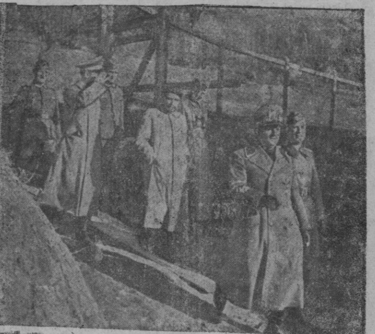
VISITAS DE IMPORTANCIA A LA «WEST WALL».—Una comisión de oficiales italianos ha visitado las fortificaciones de la Línea Sigfrido, conocidas también por la «West-Wall». Los visitantes quedaron asombrados de la magnitud de las mismas. (Cliché Welt Press).
