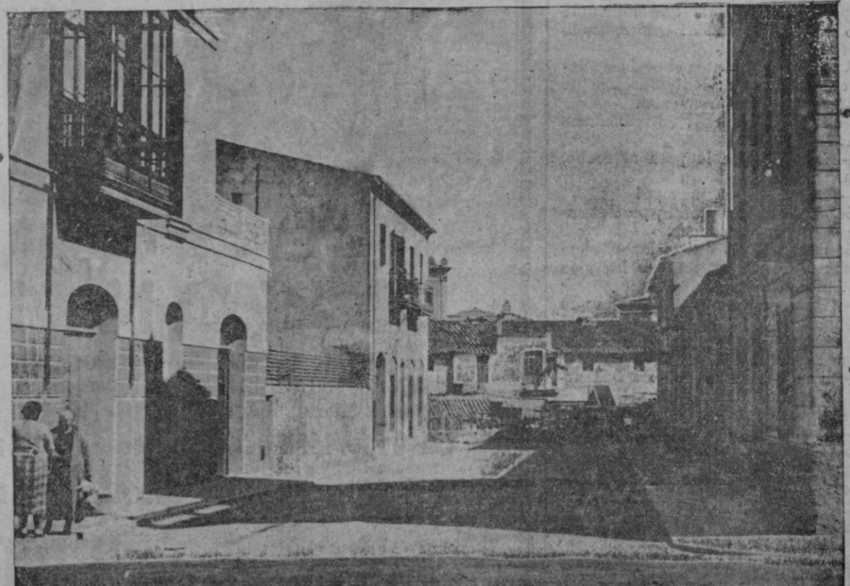
Estado actual de la calle de Gilibert de Centellas que en bre ve será comunicada con la calle de Aragón, para lo que serán derribadas las casas que se ven al fondo.
