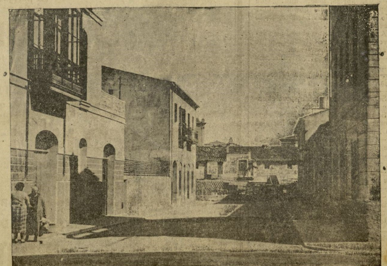
Estado actual de la calle de Gilabert de Centellas que en breve será comunicada con la calle de Aragón, para lo que serán derribadas las casas que se ven al fondo.
