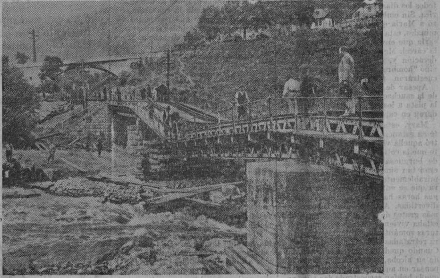
A causa del dilatamiento producido por el desbordamiento del río, en el valle de Praheva (Rumania), se hundió un puente segundos después de haber pasado un tren, lo que de ocurrir momentos después hubiese ocasionado una muerte segura a varias personas. Obreros reparando el puente.
