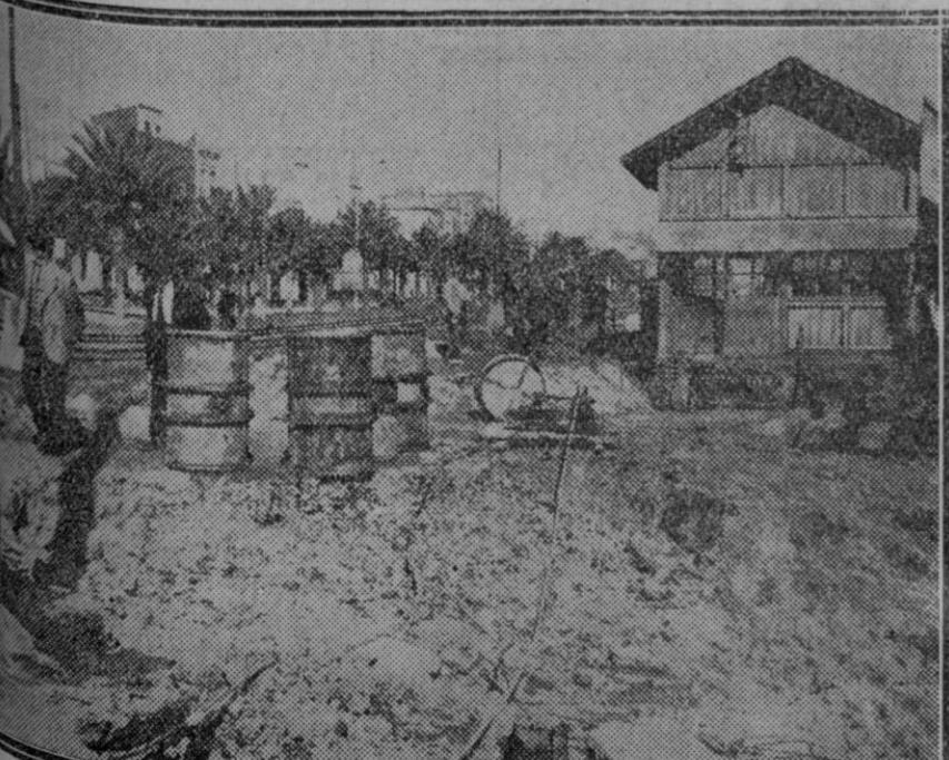
BARCELONA.—Un aspecto de como quedó la plaza de Badalona después del temporal que causó destrozos en dicha ciudad por valor de varios centenares de miles de pesetas.
