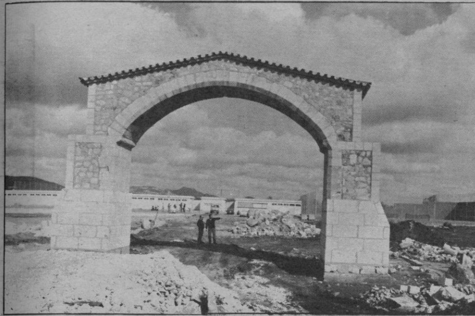
El arco de entrada al complejo, que fue desmontado pieza a pieza del interior del abrevadero, será ahora testigo —esperamos— de grandes éxitos deportivos.
