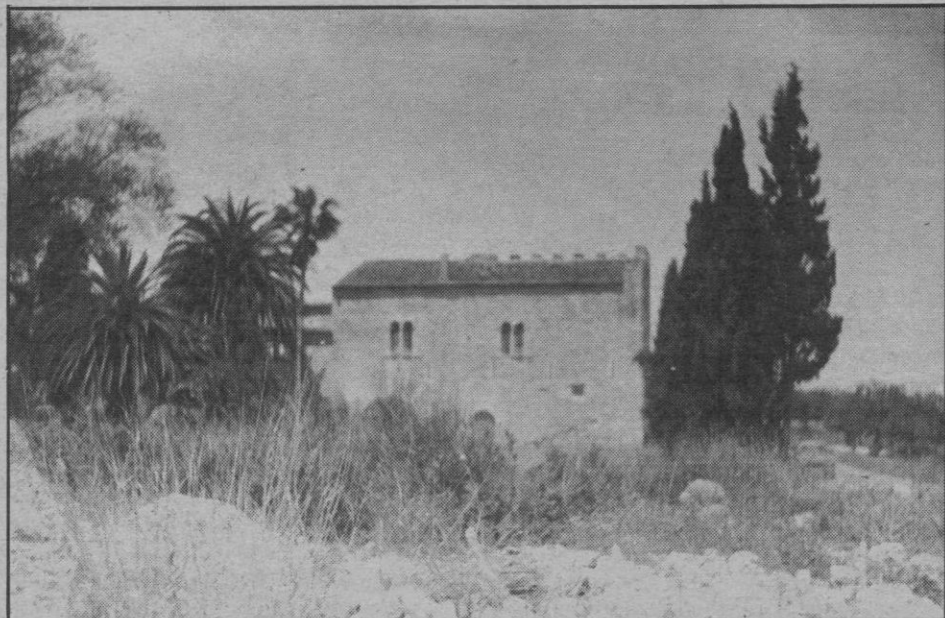
«Torre del Rei» incluida en la zona prevista para el futuro Polideportivo. (Foto ALFONSO)
